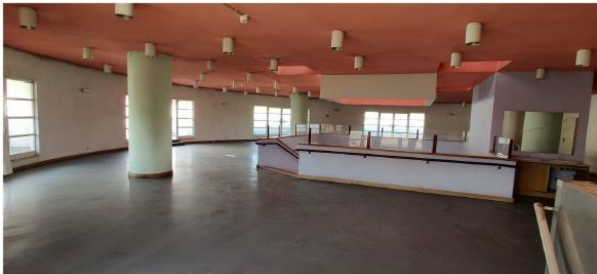
g) Restaurante / Escola (CRESCER) – reabilitação profunda concluída
